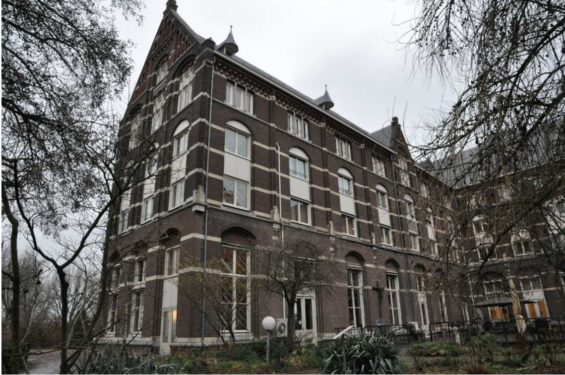
53 Noordelijke vleugel, de zuidgevel en kopgevel.
