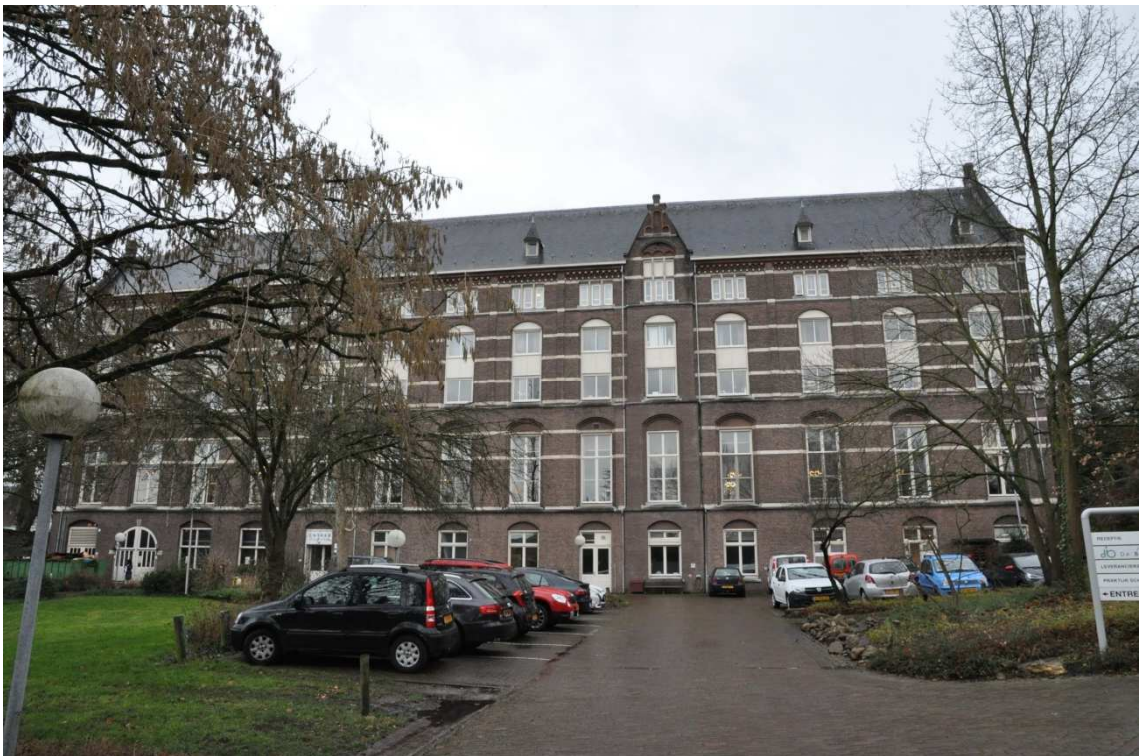
54 Noordelijke vleugel, de noordgevel.
