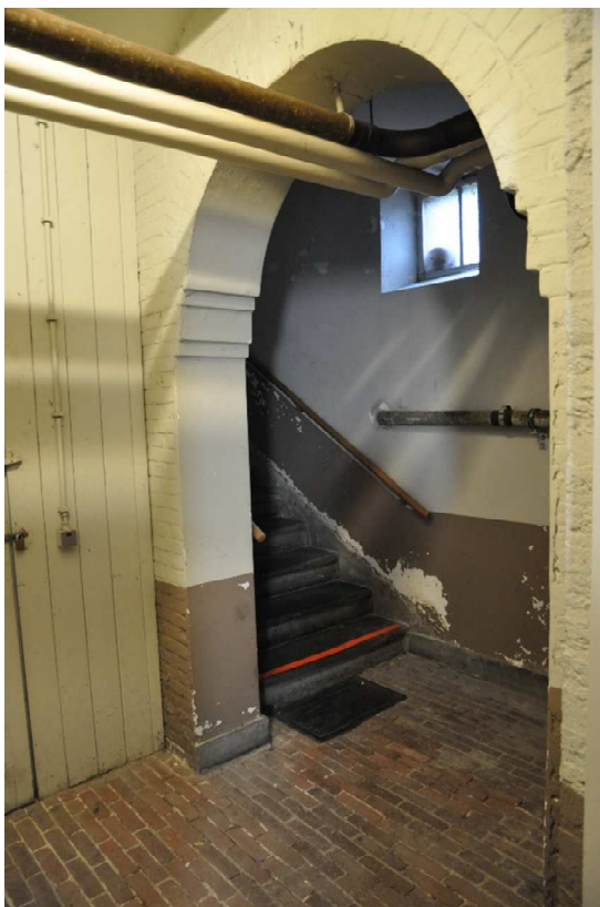
73 Trapportaal in de oude zuidvleugel.
