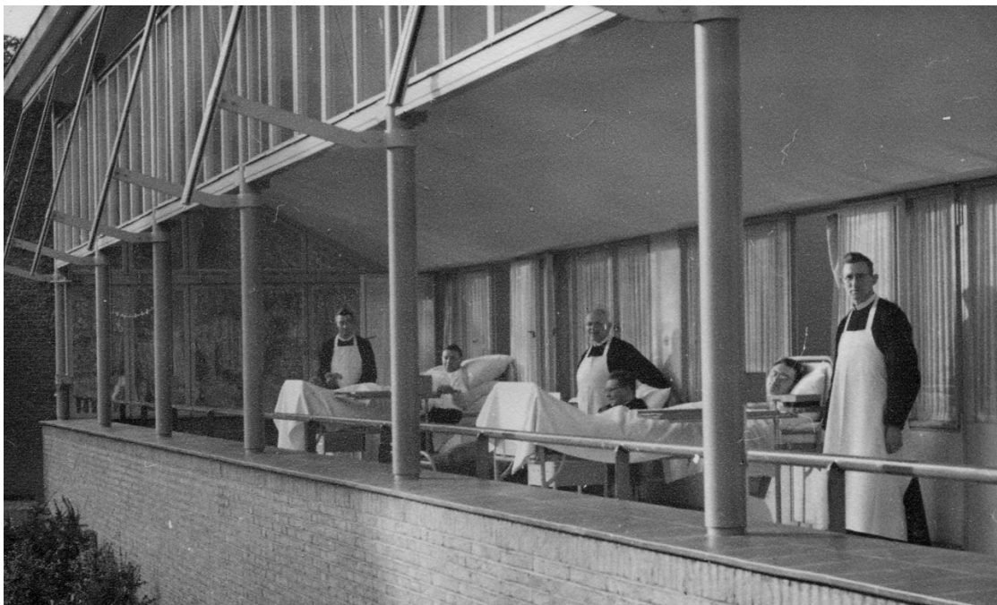
21 De veranda van het ziekenpaviljoen van de architect Boosten uit 1937 voor de behandeling van tuberculosepatiënten.
