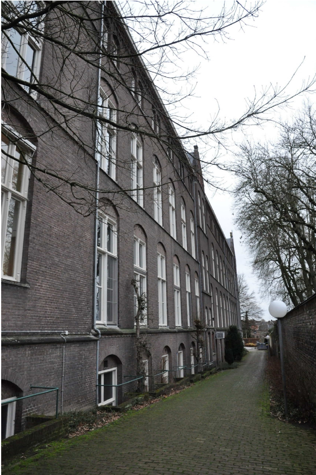
55 De oostgevel van de oostelijke vleugel gezien naar het noorden.
