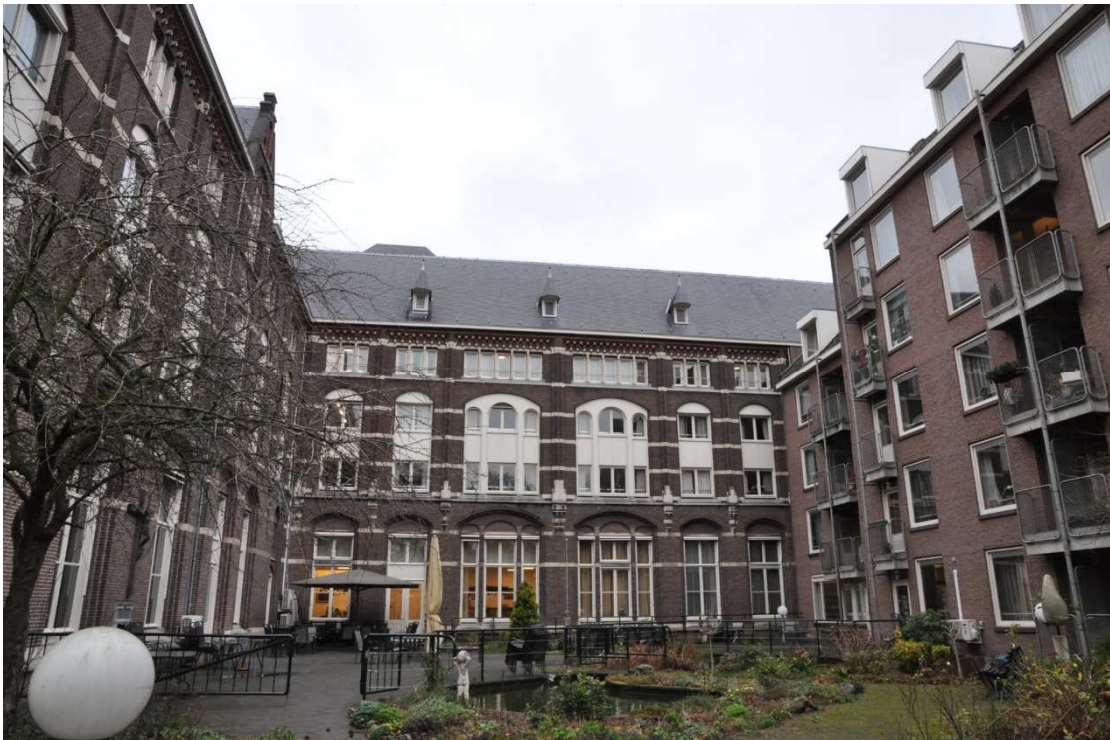
52 Middenvleugel noordelijke helft, rechts de nieuwe woonvleugel, links de noordelijke vleugel.
