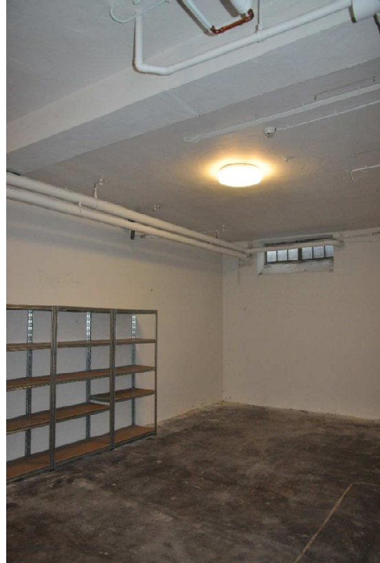
136 Eén van de kelderruimtes.
