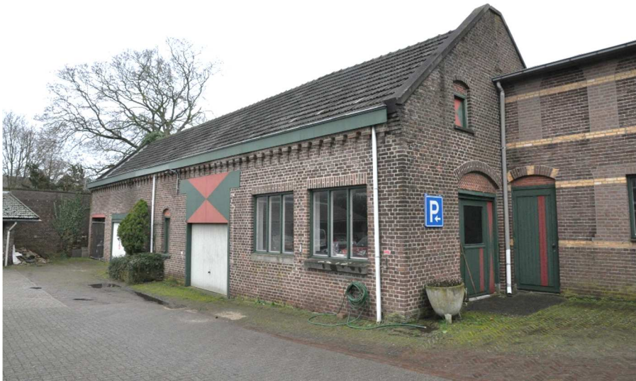
165 Het voormalige stalgebouw (vóór 1910 gebouwd)
