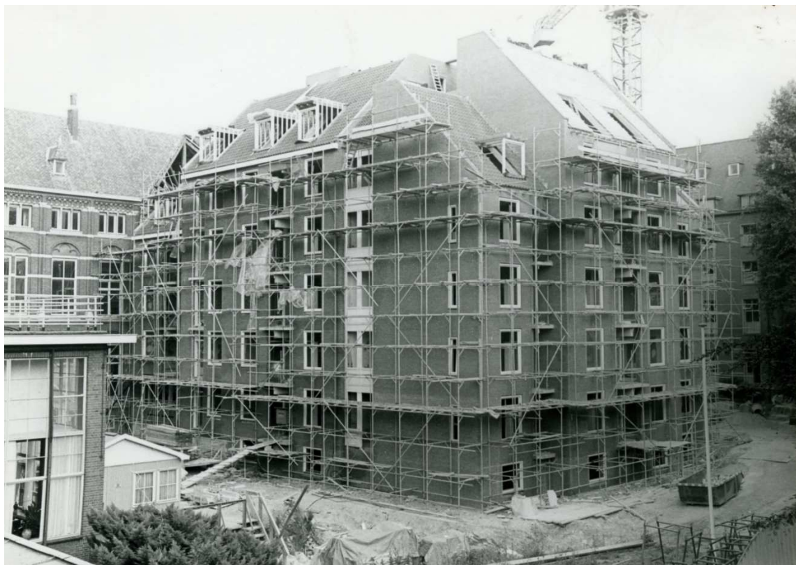
24 De bouw van de huidige woonvleugel in 1982, op de plek van de oude kapel.
