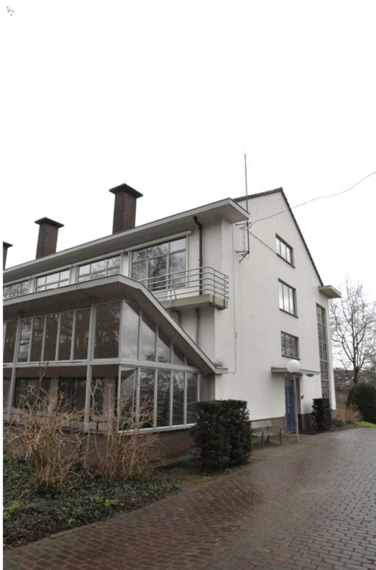
133 Lydwina paviljoen – oostelijke kopgevel vanuit het zuiden gezien.
