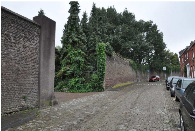
181 De huidige entree aan Hoogfrankrijk en de kloostermuur langs deze straat.
