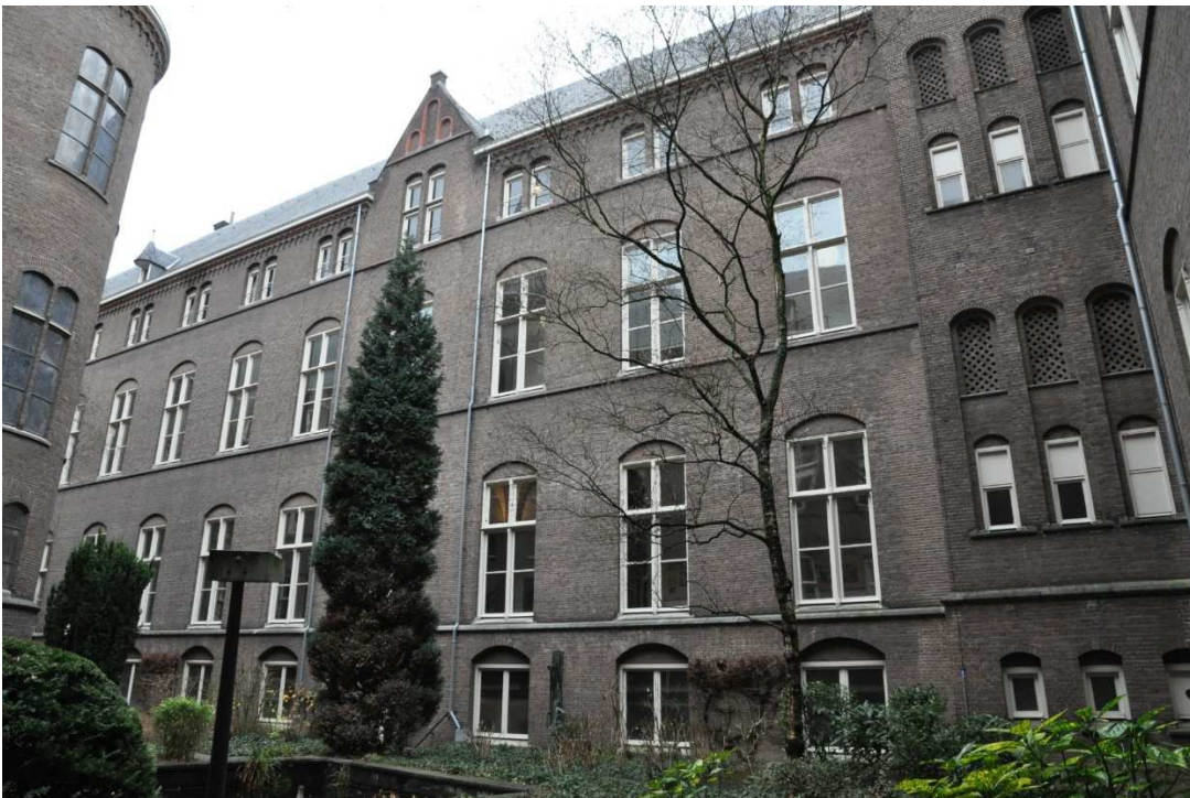
65 Binnenhof, de westgevel van de oostvleugel, rechts de zuidoostelijke toiletgroep.
