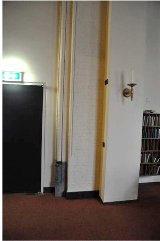
80 Bundelpijler oude kapel bij de aansluiting met de nieuwbouw uit 1982.
