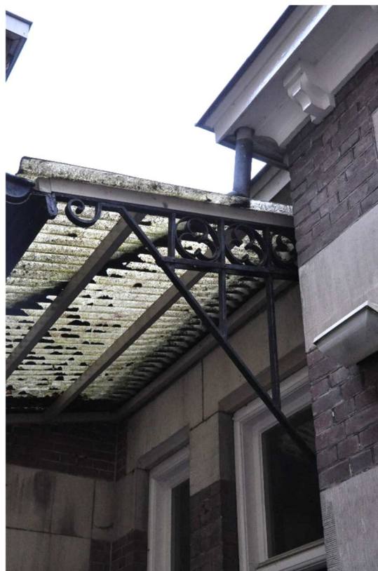
123 Afdak met oorspronkelijke consoles achter de personentoeegang van de poortmuur.
