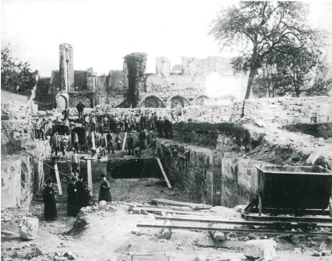
16 Foto uit 1894. De kelders van het voormalige Franciscanessenklooster tijdens de sloop van het oude klooster. Op de achtergrond de restanten van de zuidelijke kapelwand.
