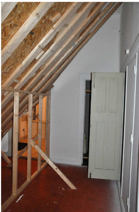
126 De portiersruimte richting het zuiden (nu grotendeels gevuld met een maquette)
