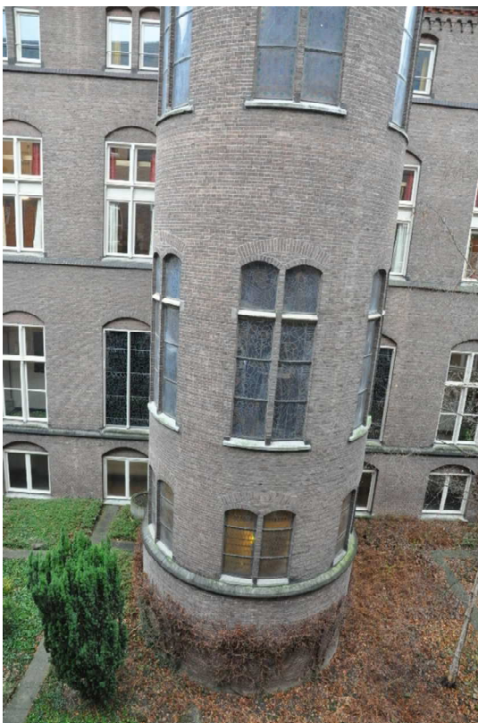
63 Binnenhof, de onderste zone van het centrale trappenhuis.
