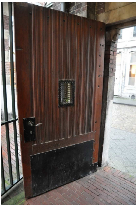
122 Oorspronkelijke personendeur aan de straat.
