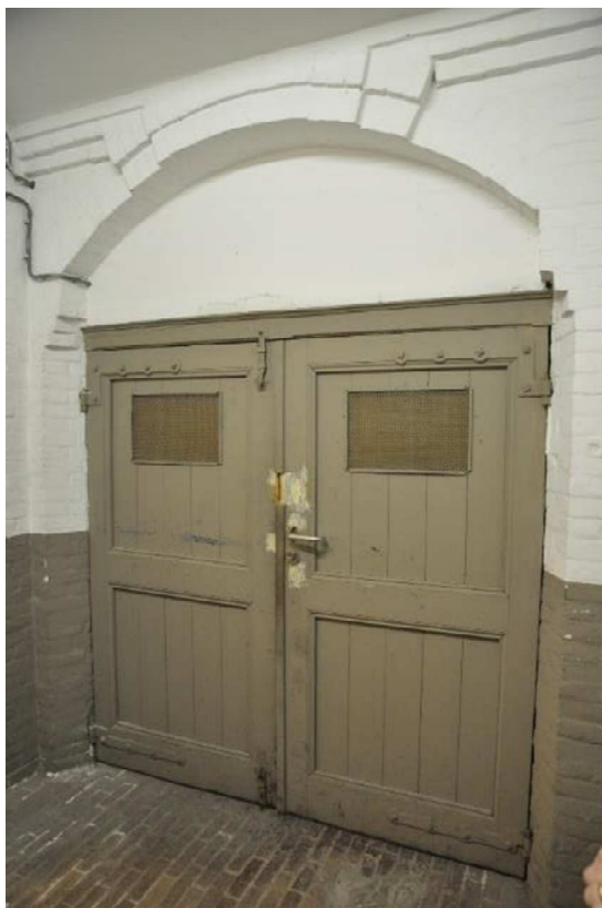
74 Eén van de dubbele opgeklampte deuren uit 1894.
