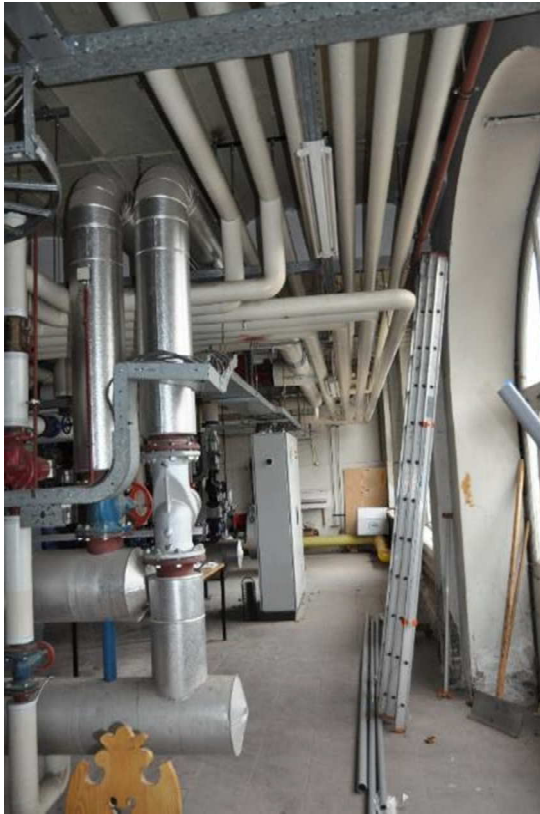
69 Interieur van de ketelruimte in de noordvleugel.
