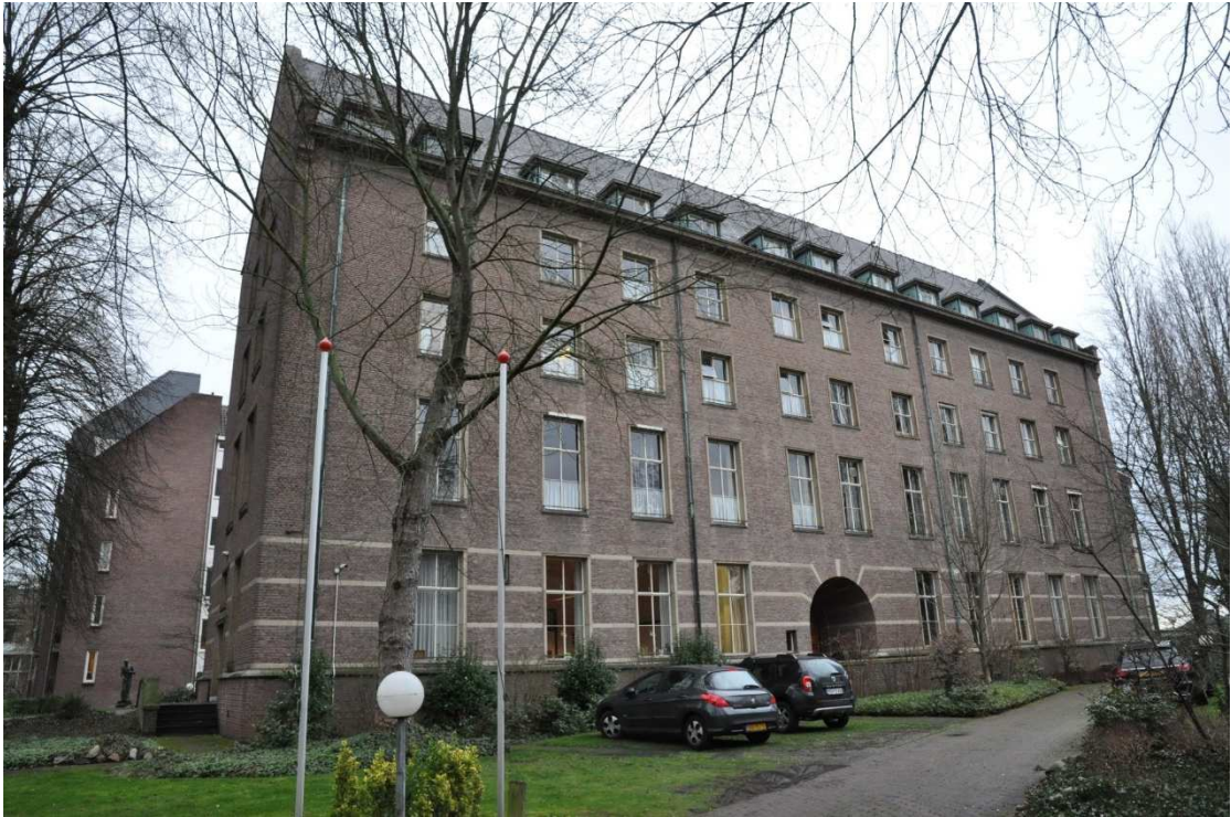
59 Boostenvleugel, zuidgevel met hoofdingang.
