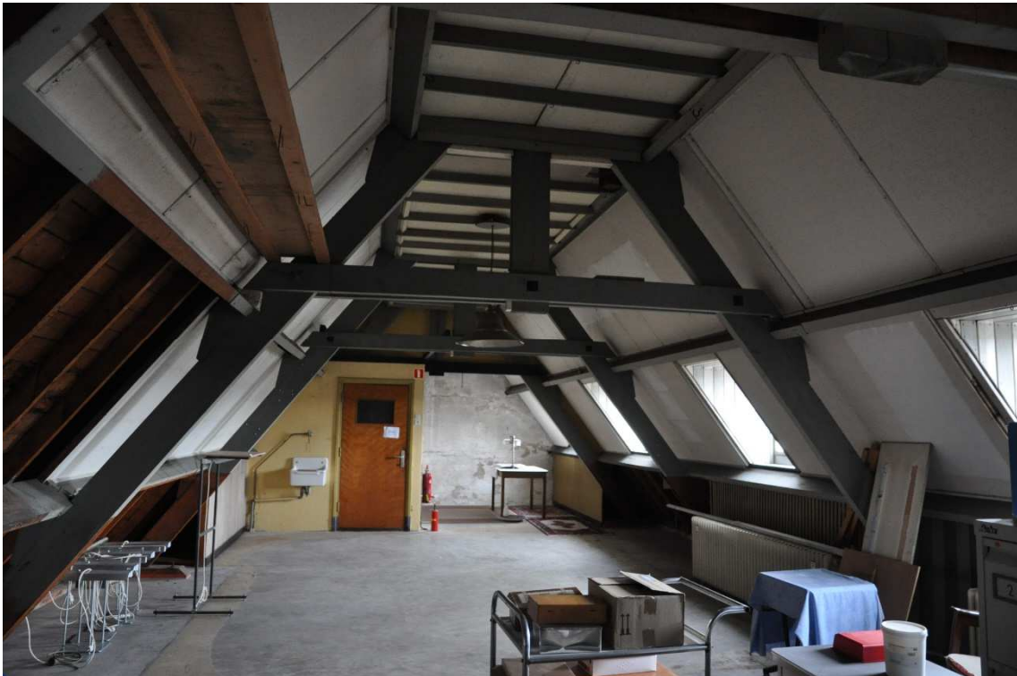
118 De kapconstructie van de Boostenvleugel, met eenvoudige naaldhouten spanten.
