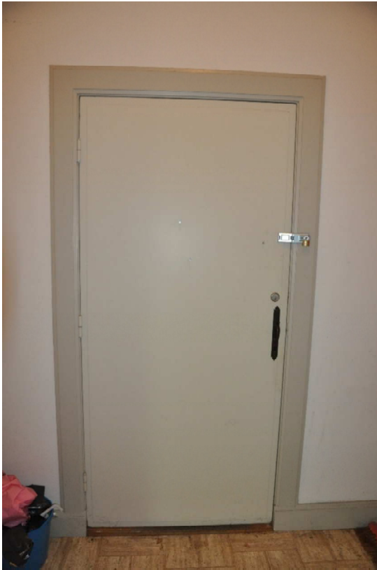
124 Eén van de vernieuwde binnendeuren.
