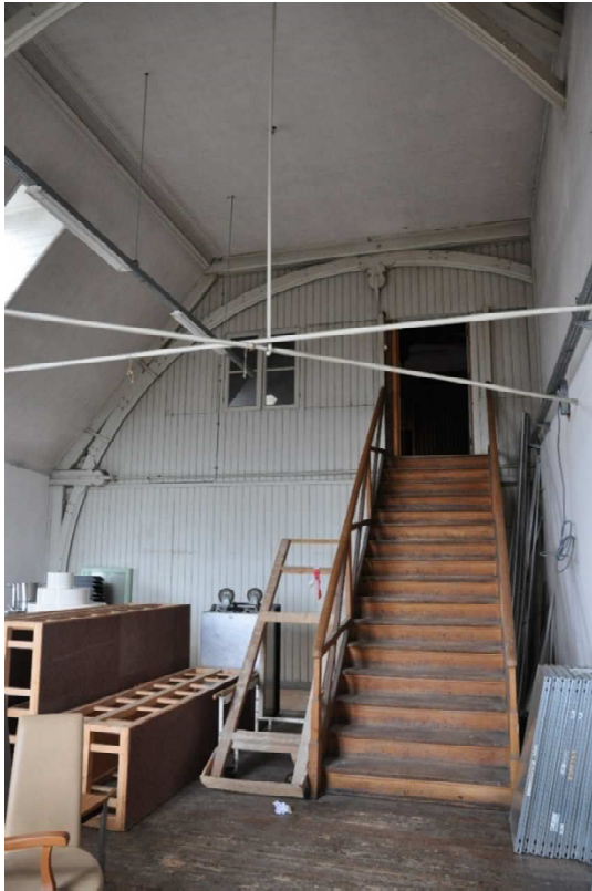
105 Zolderruimte aan de oostzijde van de zuidvleugel, met trap naar de vloering.
