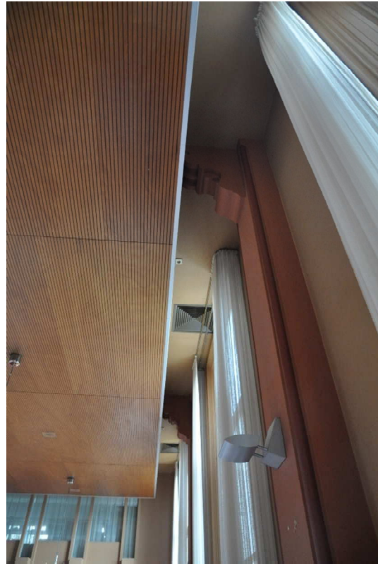
85 Verlaagd plafond en oude muurpijlers in de eetzaal.
