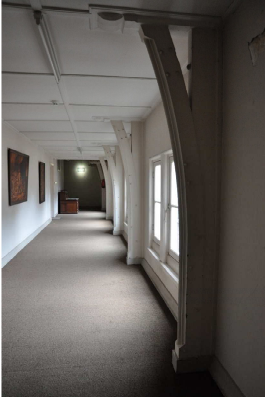
100 Tweede verdieping, gang oude zuidvleugel, met rechts de spantbenen van de kapspanten.
