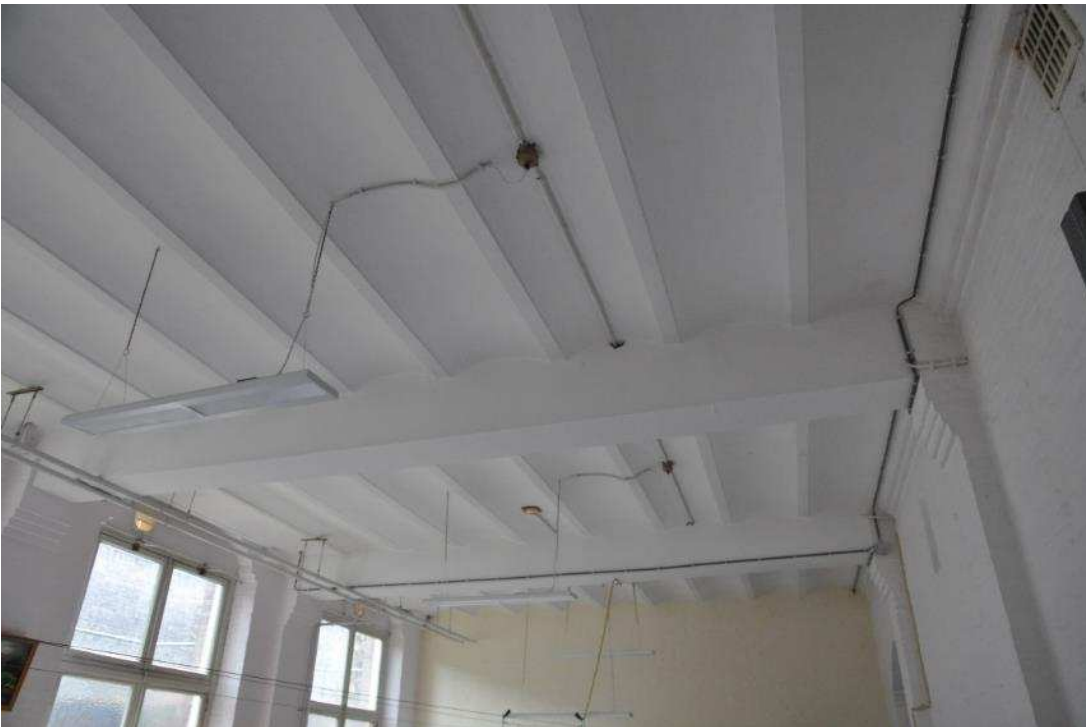
68 Interieur van de wasserij in de oostelijke vleugel, met stalen balken en bakstenen troggewelfjes.
