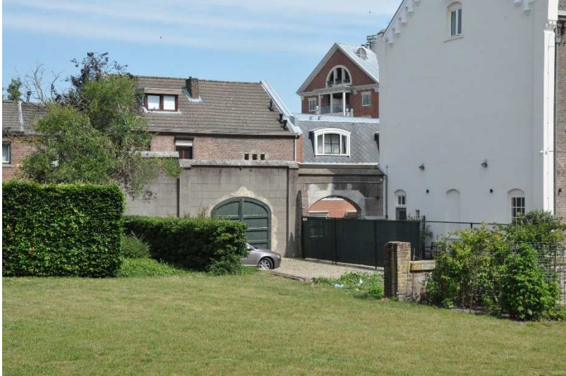
179 De kloostermuur met twee poorten aan Hoogfrankrijk: binnenzijde. Het lichte pleisterwerk rondom de poortopeningen toont dat de bogen later zijn gemaakt.
