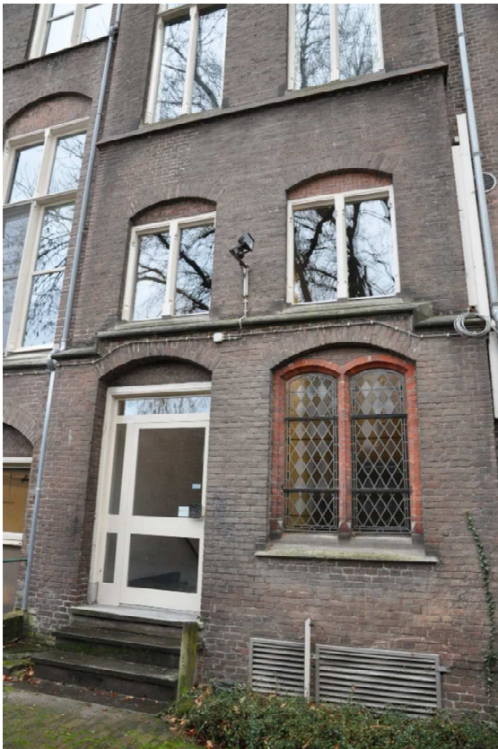
56 De entree met trappenhuis centraal in de oostelijke gevel.
