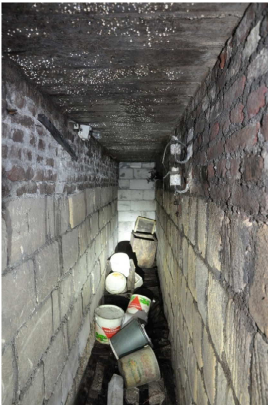
71 Funderingsmuren met in de onderste zone mergel-Blokken.
