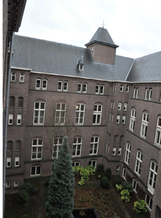
62 Binnenhof gezien naar het zuidwesten. Op de verdieping rechts de aanpassing van de ramen (3 stuks zichtbaar) a.g.v. het aanbrengen van de tussenverdieping in 1982.
