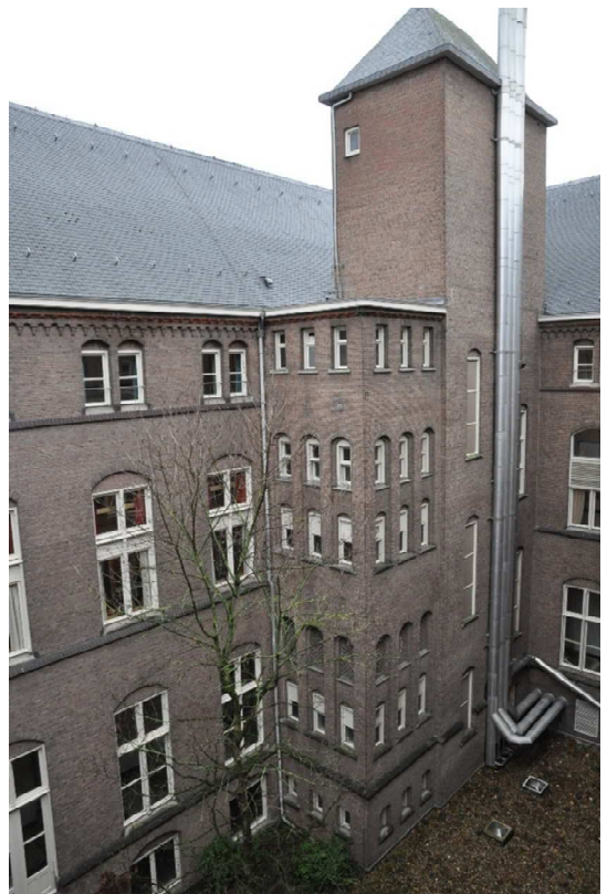
64 De noordwestelijke toiletgroep met daarachter het tot liftschacht omgebouwde trappenhuis met opgehoogd waterreservoir onder een schilddak..
