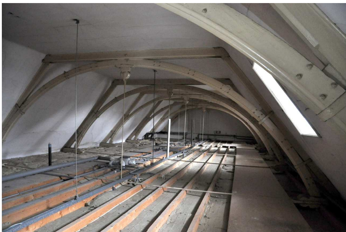
108 De kapconstructie van de middenvleugel, richting het zuiden gezien. Ten behoeve van de patiëntenkamers op de tussenverdieping is er een verlaagd plafond aangebracht.
